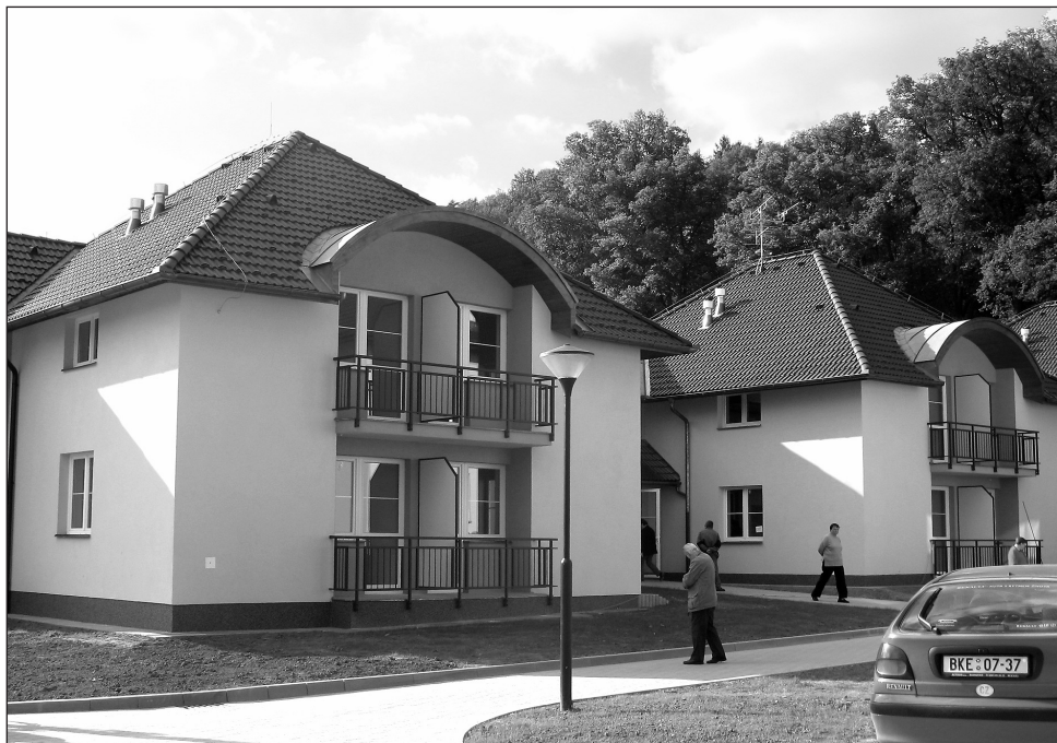
Novinka. Bytové domy v Halasově ulici v Lysicích.
