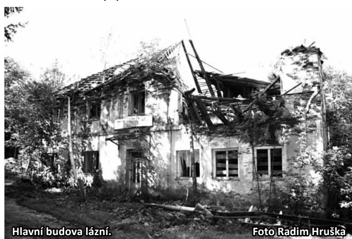
Hlavní budova lázní.
