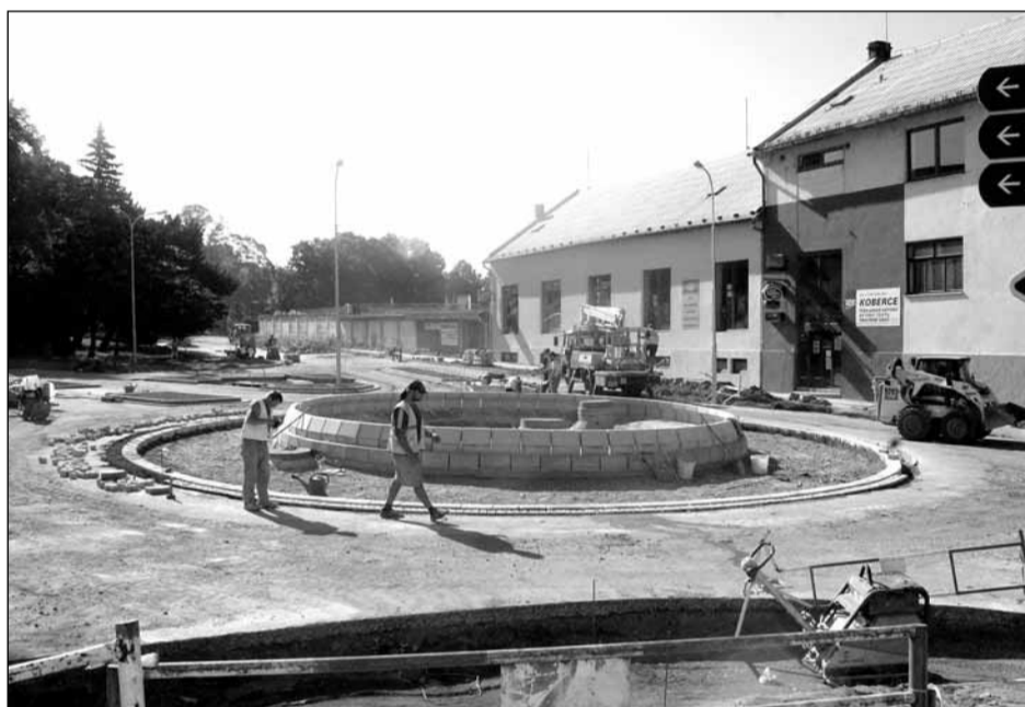
Kruháč. Omezení dopravy ve středu Blanska nečiní takový problém, jak se někteří obávali. Výstavba okružní křižovatky u budovy bývalého okresního úřadu úspěšně pokračuje. „Podle mých informací jde vše podle plánu,“ je spokojen místostarosta Ivo Polák. Uprostřed staveniště již vznikl středový prstenec. Foto Bohumil Hlaváček
