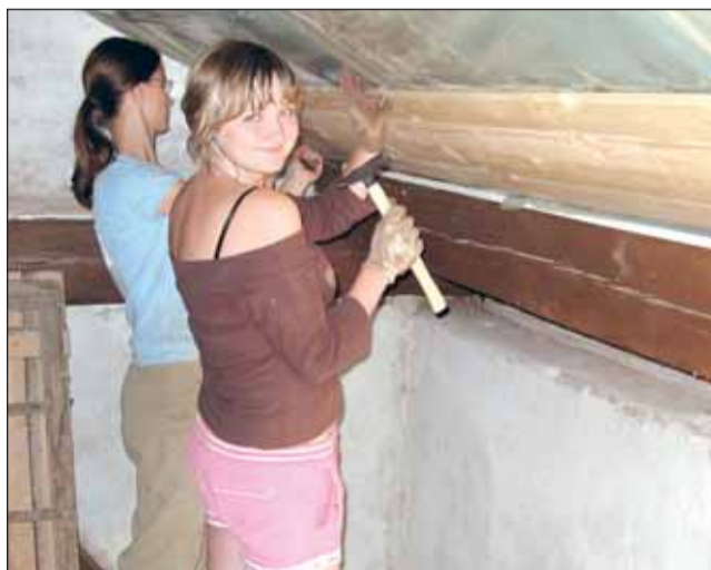
Při práci. Studenti právě pracují na zateplení střechy budoucího Haczka.
