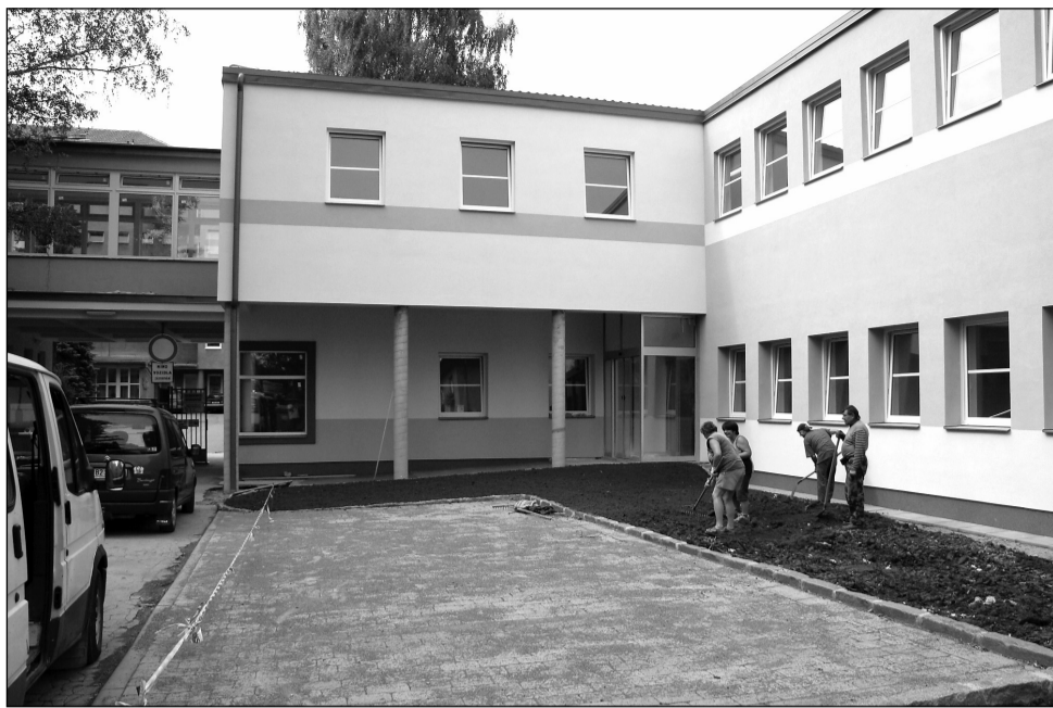
Finiš. Stará lékárna kompletně změnila tvář a rozrostla se o jedno celé patro. Foto Radim Hruška
