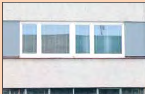
Obrázek 1: Systém oken SULKO PROFI Line byl využit i pro energeticky uvědomělou výměnu oken a meziokenních vložek panelového domu typu HK69. Na snímcích lze pozorovat povrchové teploty rámu a skel téměř shodné s venkovní teplotou (žádné prohřívání konstrukcí okna unikajícím teplem).
