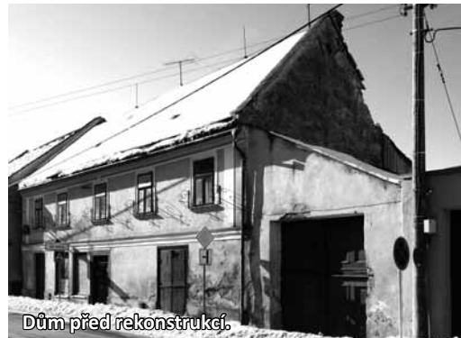
Dům před rekonstrukcí.
