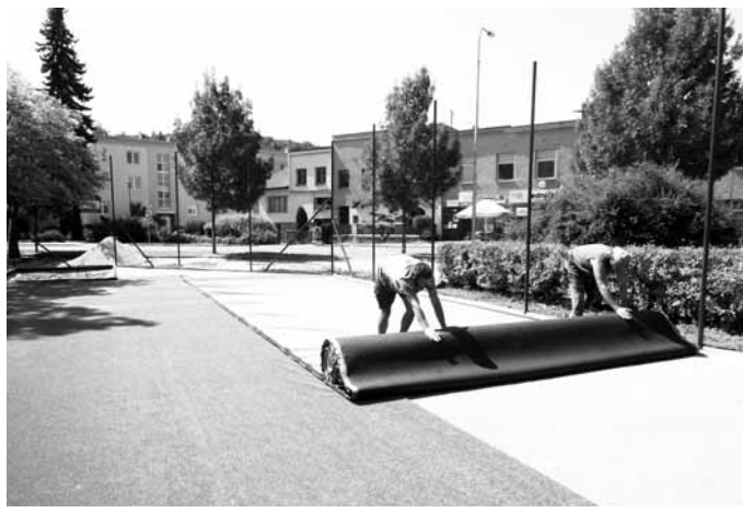
Před dokončením. Dělníci pokládají umělý povrch na hřišti u pracoviště na nám. 9. května.
