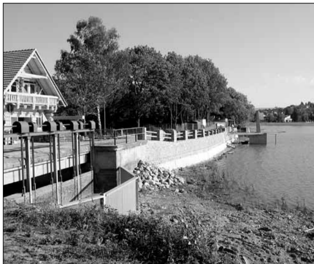
Olšovec. Opravami prošla také hráz jedovnického rybníka.
