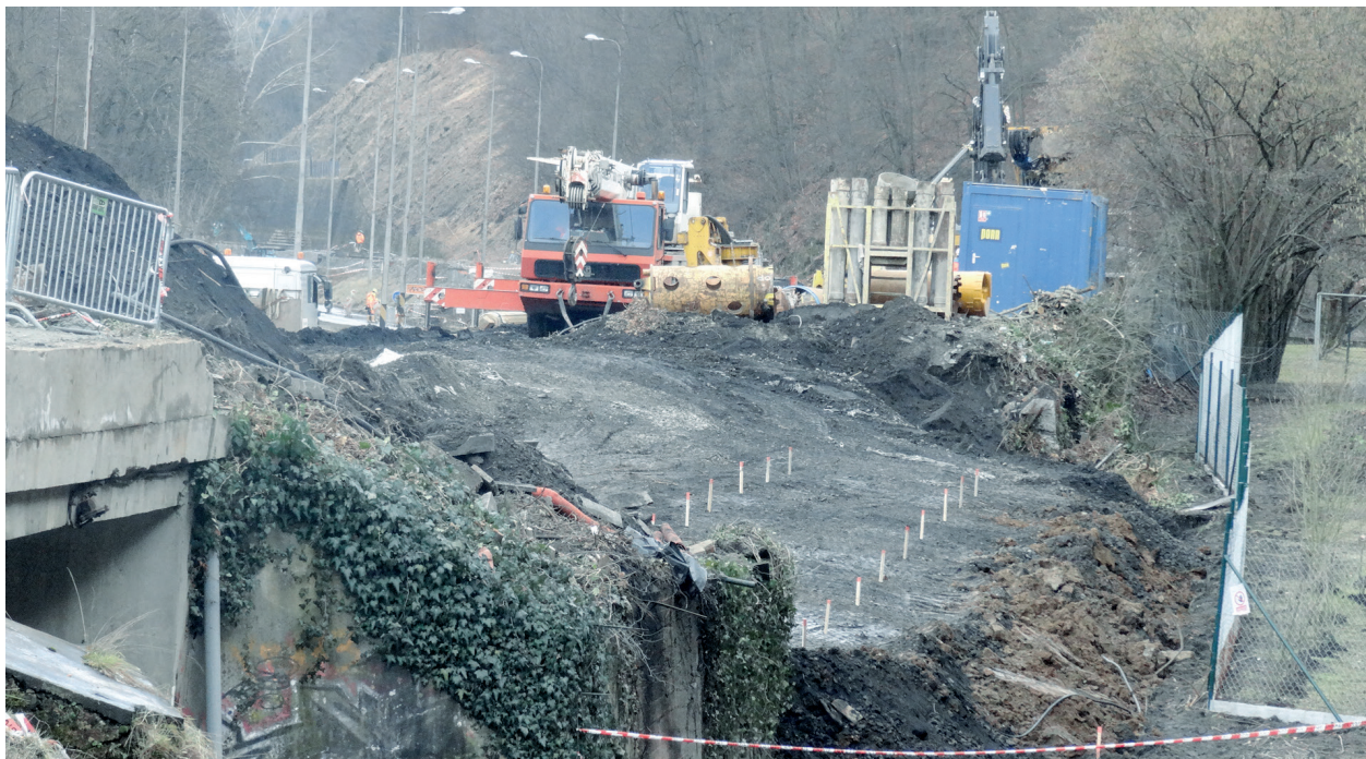
Práce na vlakovém koridoru pokračují. V Adamově probíhá také rekonstrukce tamního nádraží. Fotoreportáž naleznete na straně 9. Foto Jaroslav Oldřich
