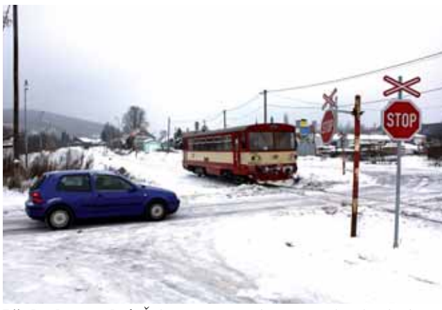
Před rekonstrukcí. Železniční přejezd v Dřevařské ulici bude mít nové závory. Foto Radim Hruška
