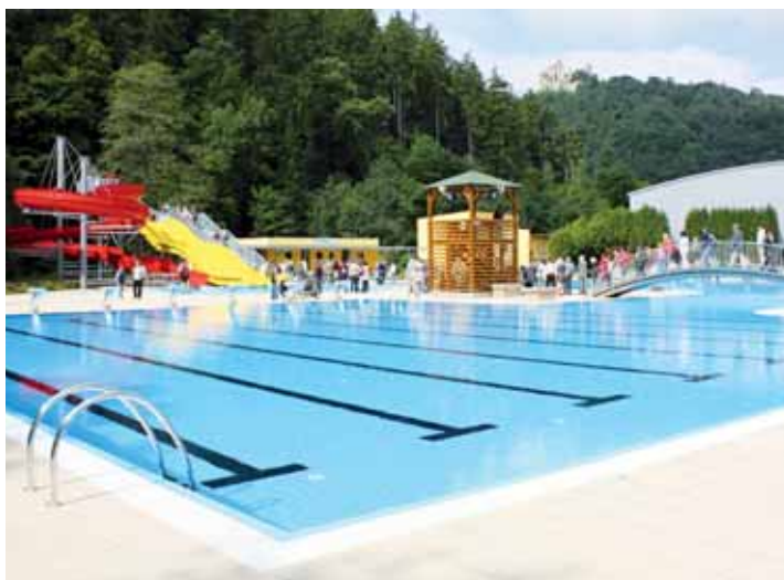
Boskovické koupaliště se dočkalo kompletní rekonstrukce. Lidé mají k dispozici plavecký bazén i řadu relaxačních prvků.
